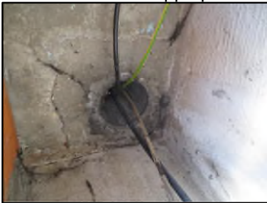
Photo N° 665 AMIANTE CIMENT -- Gaine technique Gaz - 4 Conduits Ventilation haute (Fibres-ciment)
